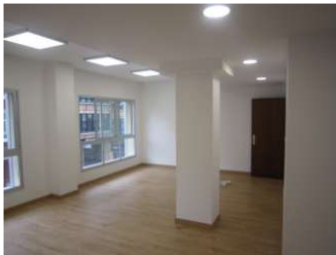
Antigua vivienda de conductores del Parque Móvil del Estado en Coruña. Mejora de los accesos.
