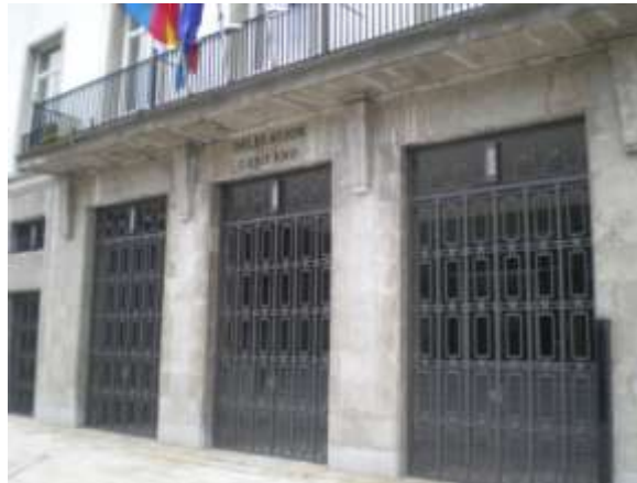
Delegación del Gobierno en Asturias. Instalación de Barandilla.
