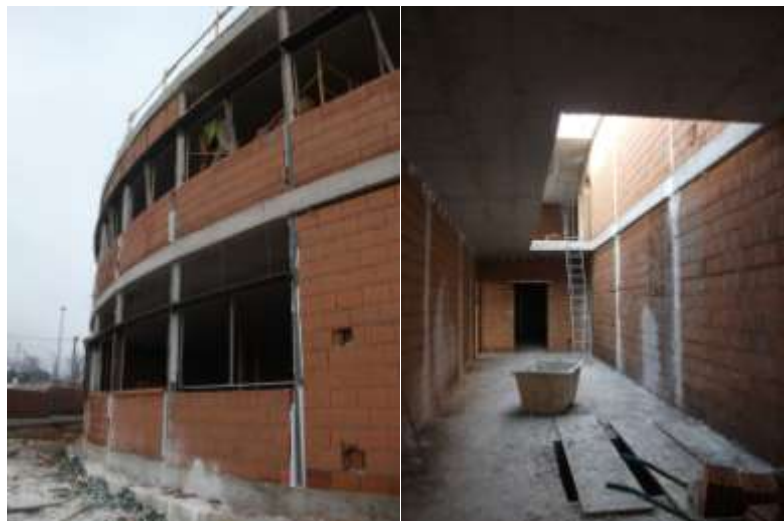
Obra de Área de Sanidad en Toledo
