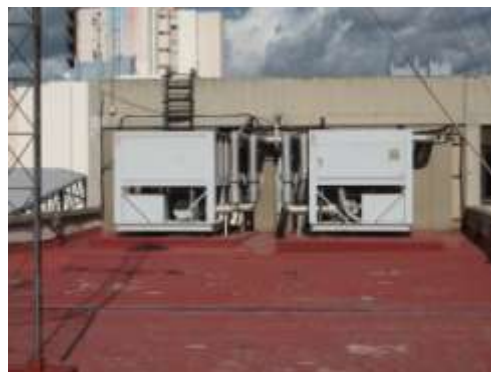
EASM en Mallorca. Mejoras en azotea.
