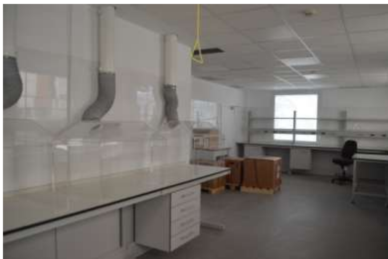
Laboratorio de Valencia. Mejoras de climatización y extracción.
