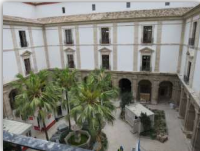
Rehabilitación de fachadas del Palacio del Temple
