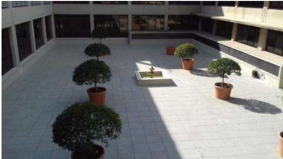
Estado final de las obras ejecutadas en el patio
