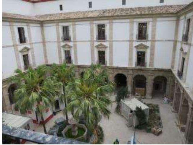
Rehabilitación de fachadas del Palacio del Temple
