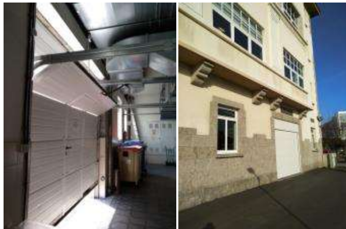
Vista de las puertas (interior y exterior)
