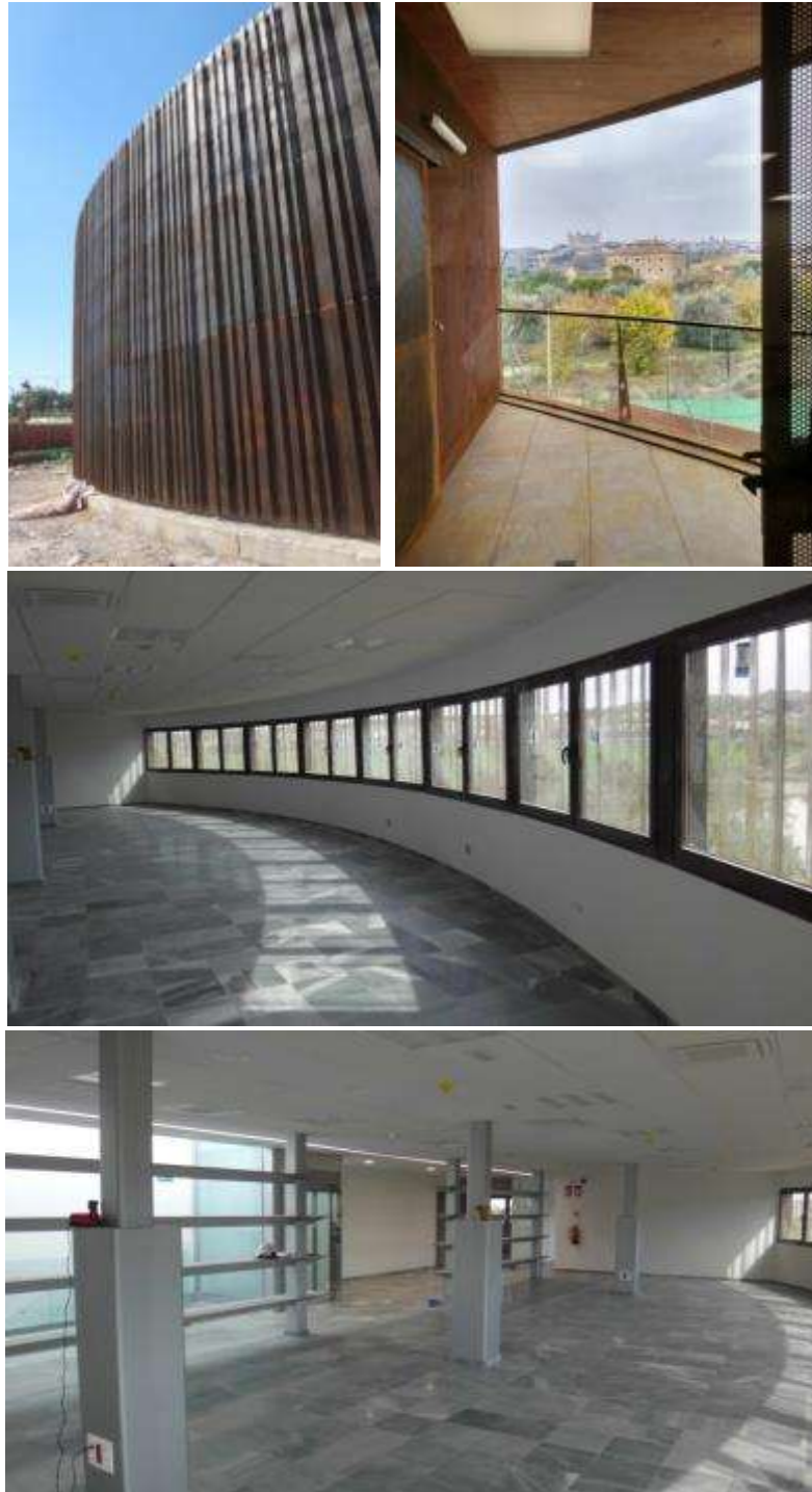
Obra del Área de Sanidad en Toledo
