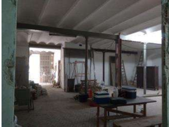
Obras de adecuación para archivo en la Delegación del Gobierno en Andalucía
