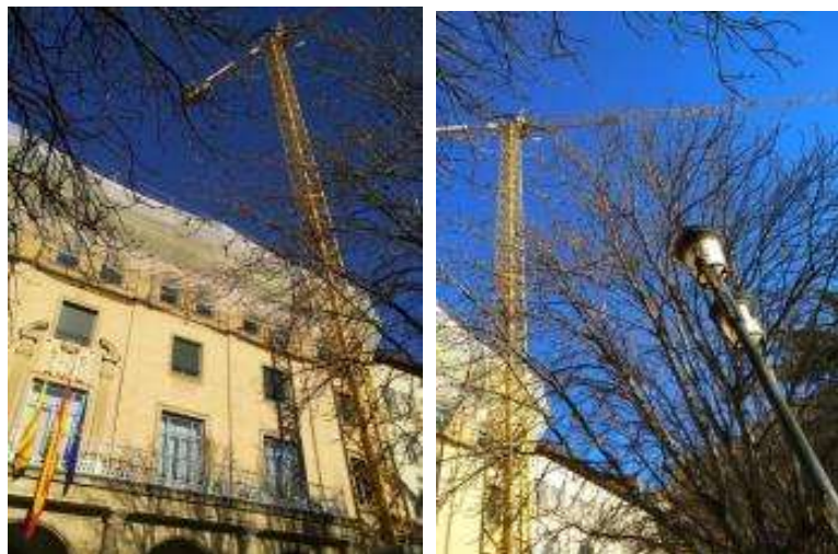
Grúa y andamios en obra
