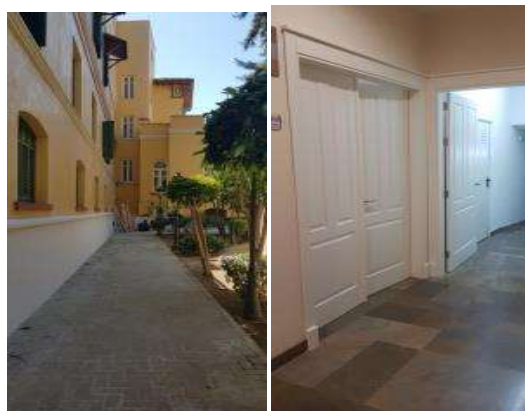
Obras de reparaciones de zócalos y puertas en Subdelegación del Gobierno en Málaga
